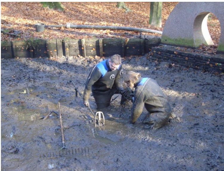
Fig. 5.1 Voorbeeld van een combinatie van oude bakstenen beschoeiing (rechts) en nieuwere, vervangende houten beschoeiing (links).
